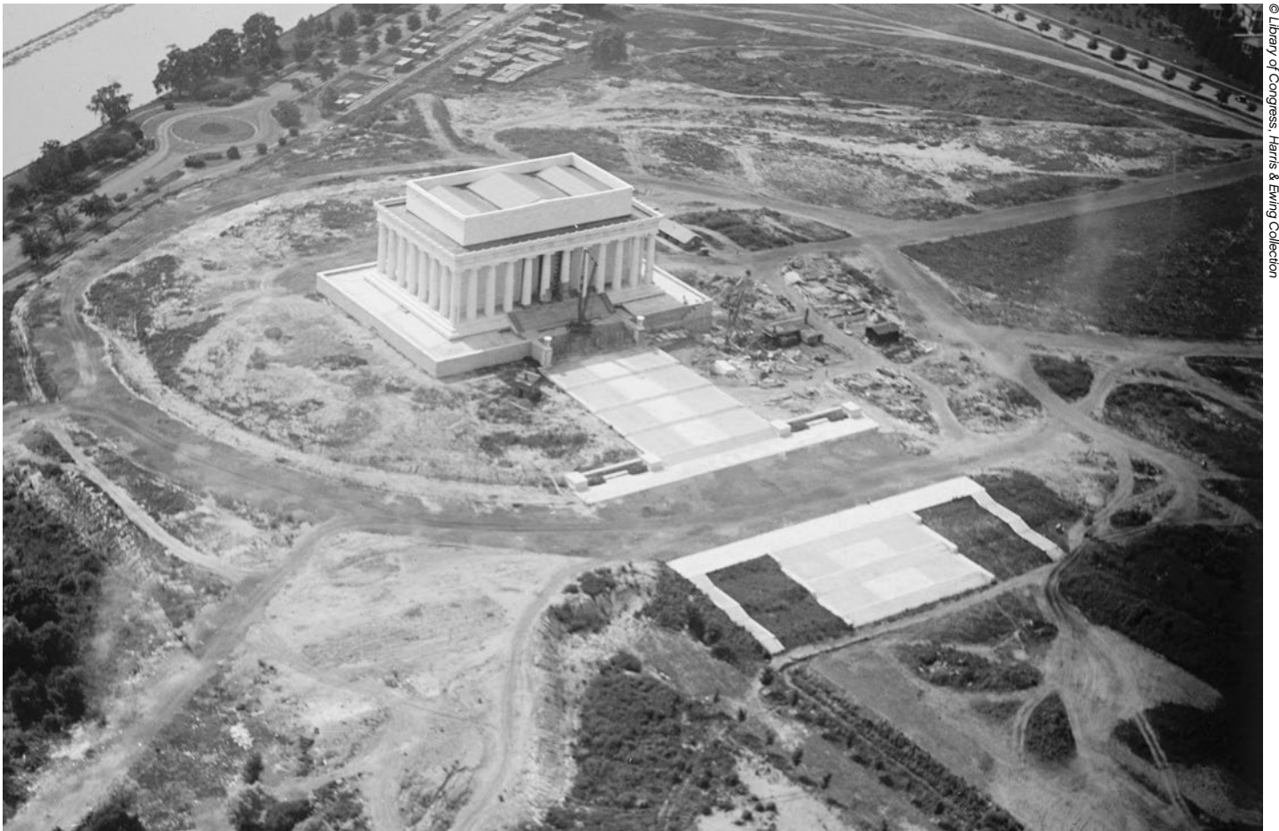
El Monumento a Lincoln durante su construcción, 1919
