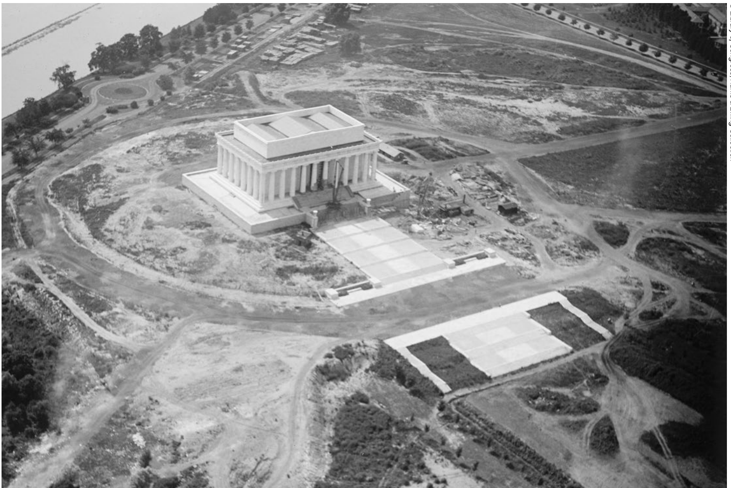
El Monumento a Lincoln durante su construcción, 1919
