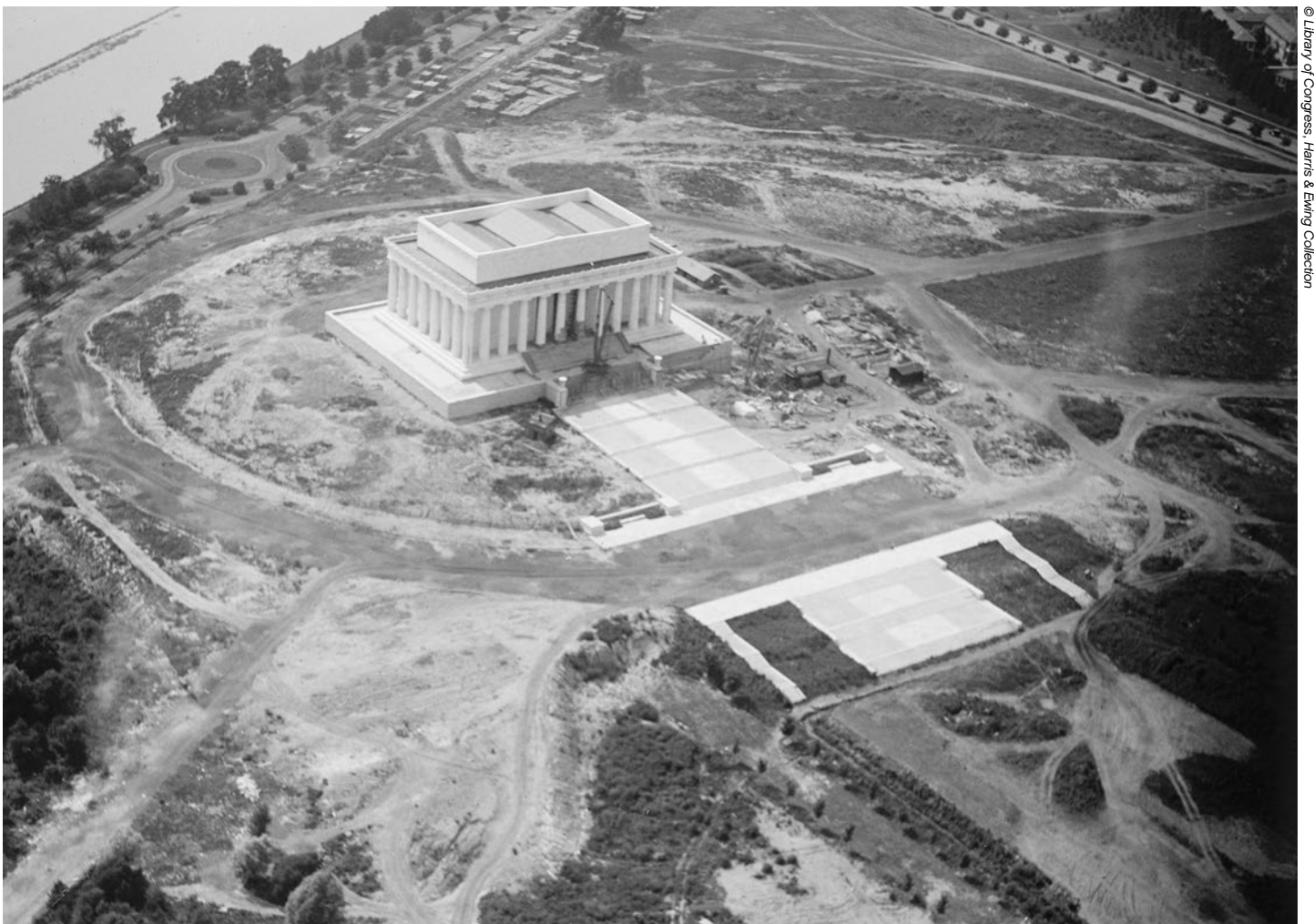
La construction du monument de Lincoln, 1919
